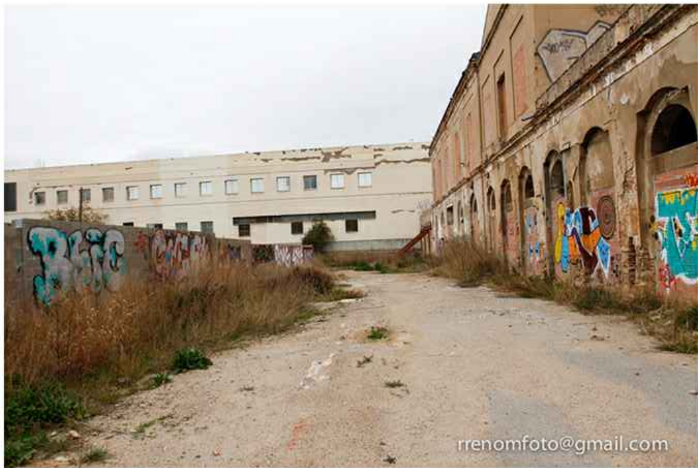
FOTO 4 : ZONA 2 | 3 FAÇANA PRINCIPAL
