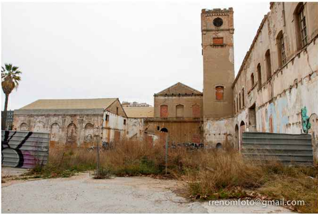
FOTO 6 : ZONA 3,4,5,6,7 | 8 FAÇANA POSTERIOR COS PRINCIPAL
