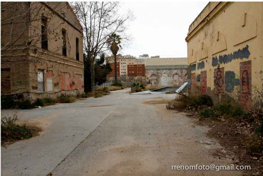
FOTO 14 : ZONA 6 | 11 FAÇANA LATERAL SUD EST
