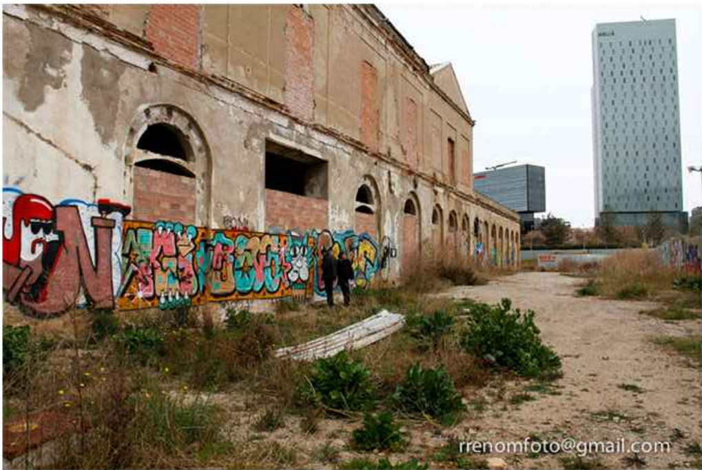
FOTO 3 : ZONA 2,3 | 5 FAÇANA PRINCIPAL
