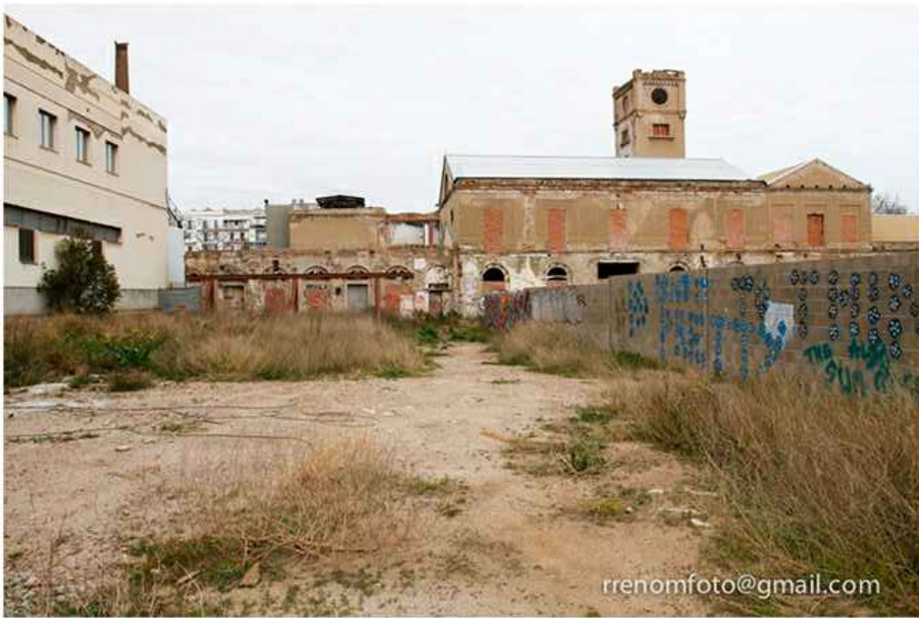
FOTO 2 : ZONA 1 | 2 FAÇANA PRINCIPAL
